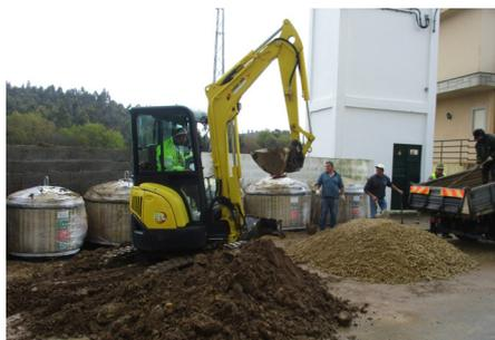
Construção de muro e instalação de Moloks (contentores subterrâneos) na Urbanização da Gândara
